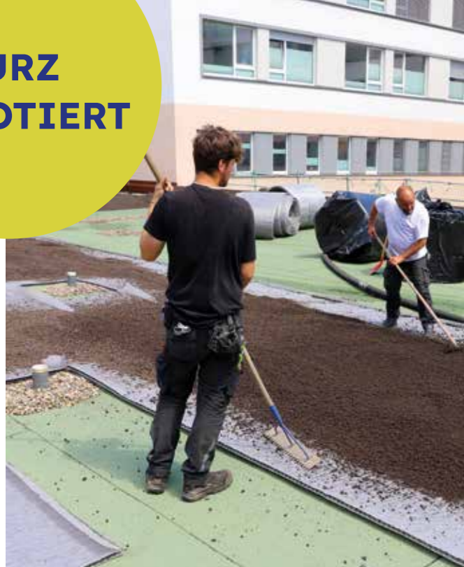
Mitarbeiter der Dachdecker-Firma bringen die Vegetationstragschicht auf das OP-Dach auf, wo bald eine 800 Quadratmeter große wilde Blumenwiese blühen wird.
